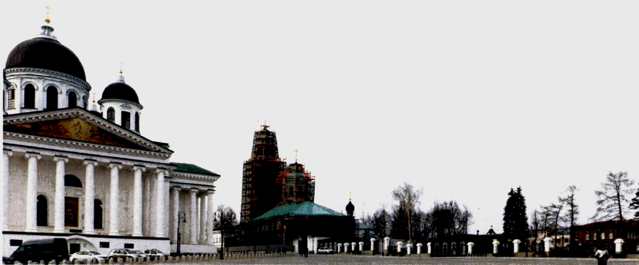
1.9. Вид пл. Соборной с востока
