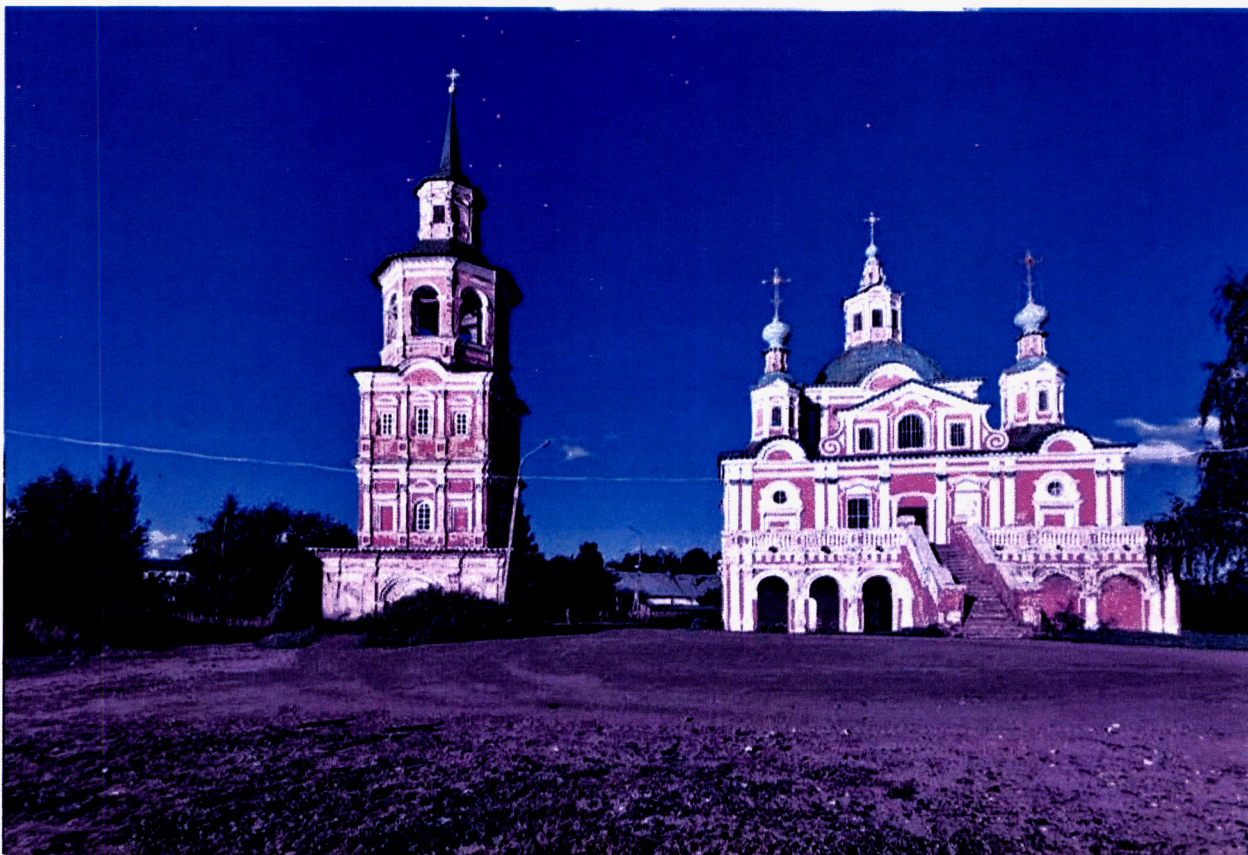
3.34. Вид в северо-восточном направлении с ул. Набережной на церковь Симеона Столпника
