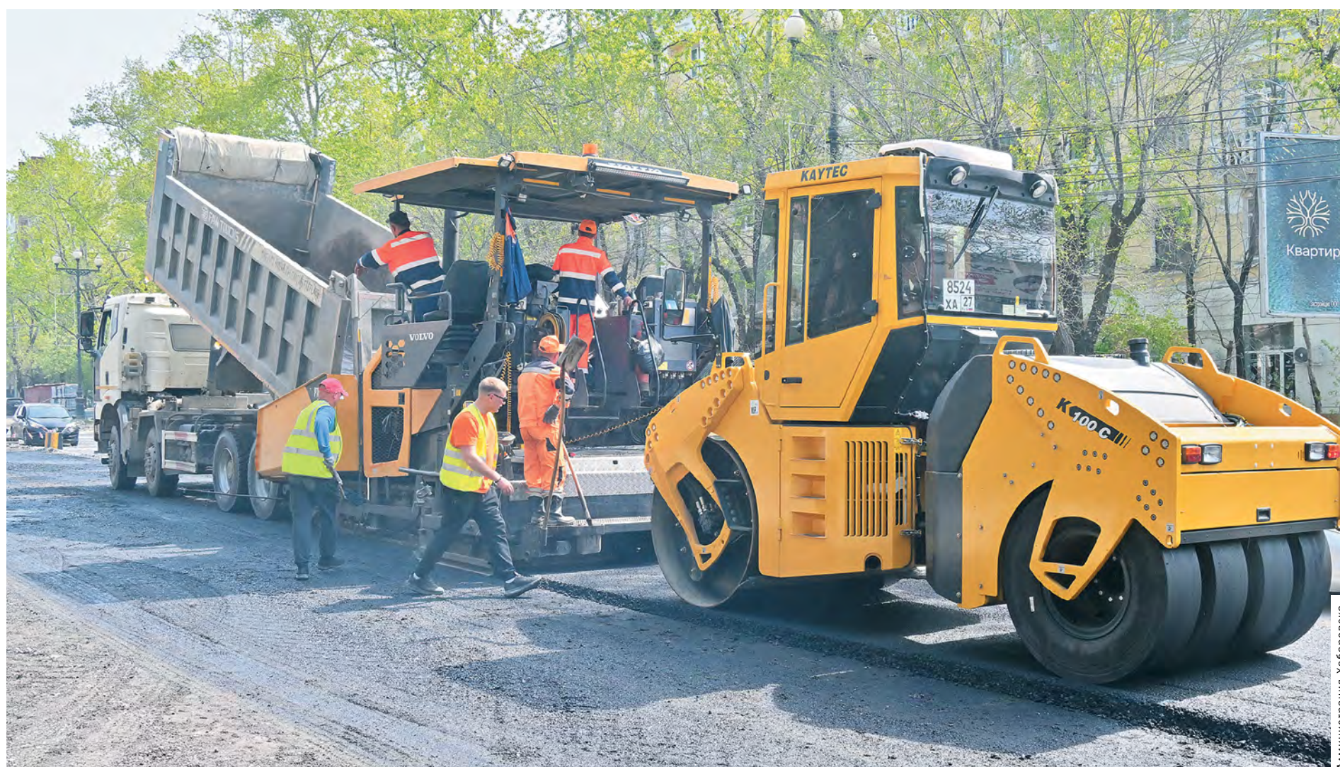
По поручению администрации подрядчик проводит асфальтирование городских магистралей.
