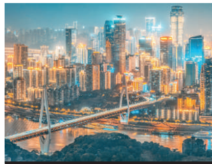
Мост Цяньсымэнь пересекает реку Цзялин с вантовым главным пролетом длиной 312 метров.
