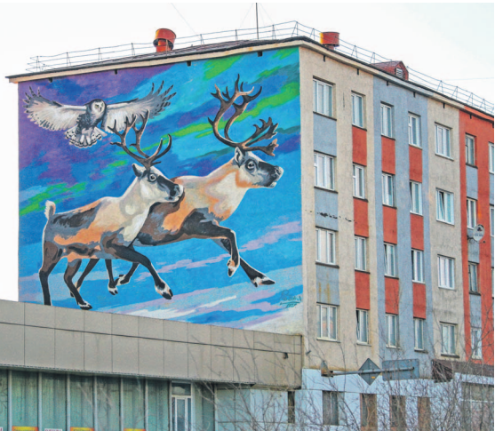
В строительство арендных домов в Арктической зоне может быть инвестировано около 20 миллиардов рублей.
