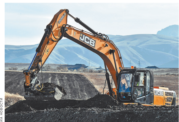
Часть золошлаковых отходов, которые генерируются отечественными угольными электростанциями, идет в дорожное строительство.
