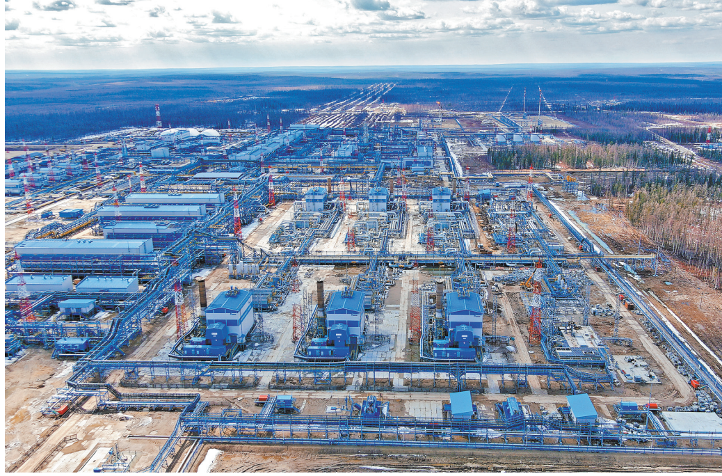
Подключение «Силы Сибири» к единой сети обеспечило надежное электроснабжение.
