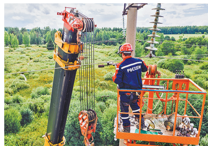
В 2024 году будет выполнена реконструкция более 124 километров линий электропередачи 0,4–10 кВ.
